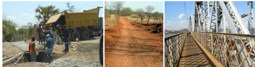
Figura 51 – Trabalhos de Reabilitação na N322; Ponte Dona Ana (Linha do Sena)
