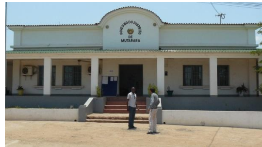
Figura 19 – Edifício do Governo Distrital
